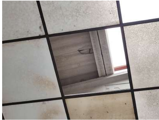
Fotografia on es pot veure les peces de fibrociment trencades
